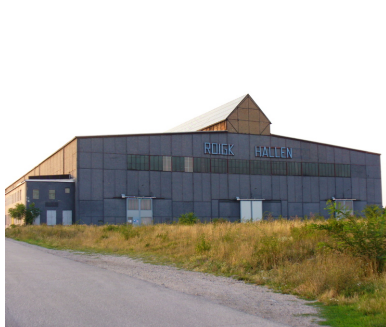
Die Raxwerkhalle heute
