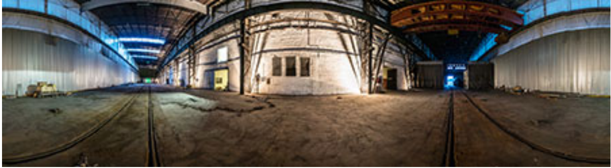
Die Raxwerkhalle heute
